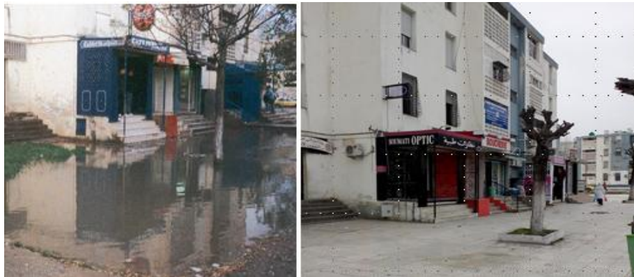
Photos 1 et 2 : La cité 1276 logements (en 2004) submergée par les eaux de pluies et actuellement (2018) après la rénovation du réseau d'assainissement (Source, Mebirouk, 2004 et auteur 2018).
